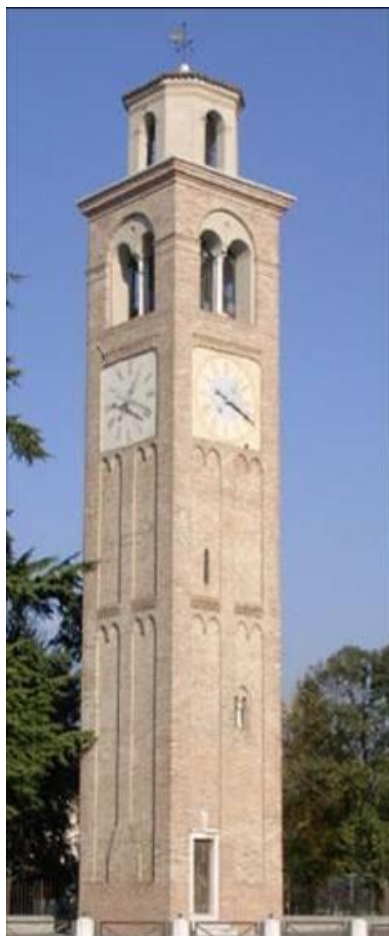
Campanile della chiesa di San Vito e Modesto
